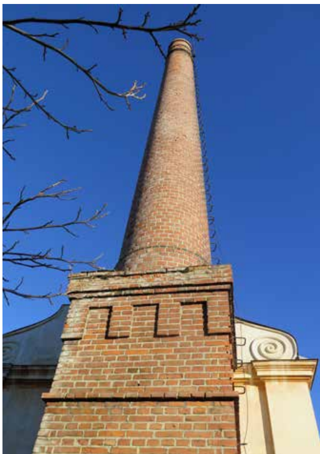
Obr. 8. Horažďovice, čerpací stanice parostrojní drážní vodárny, detail komínu, pohled od jihu, zdroj: NPÚ, ÚOP v Plzni, foto: autor, 2023
