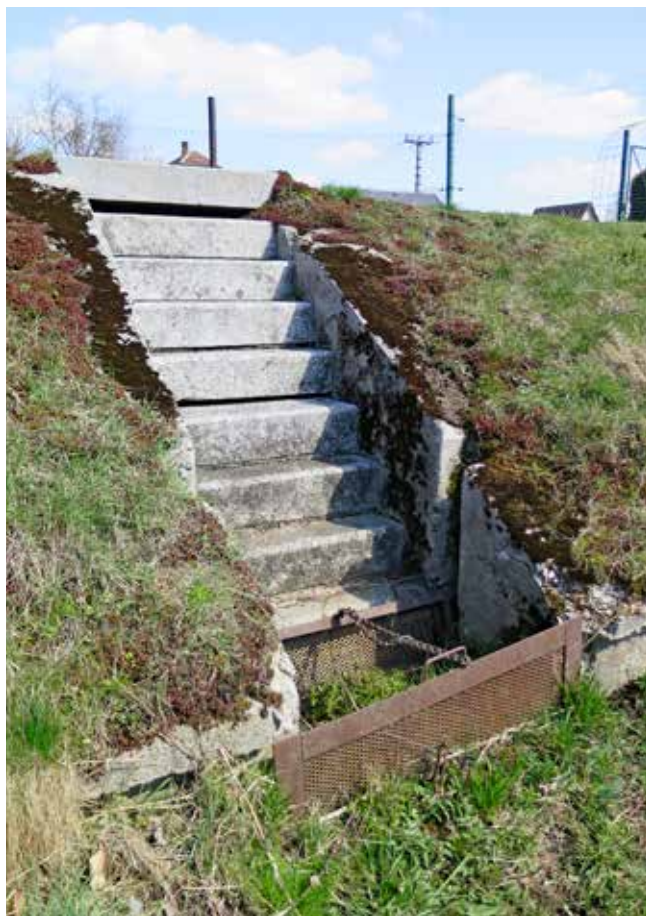
Obr. 11. Horažďovice, čerpací stanice parostrojní drážní vodárny, jímací zařízení s česlem na břehu řeky Otavy, pohled od jihozápadu, zdroj: NPÚ, ÚOP v Plzni, foto: autor, 2023
