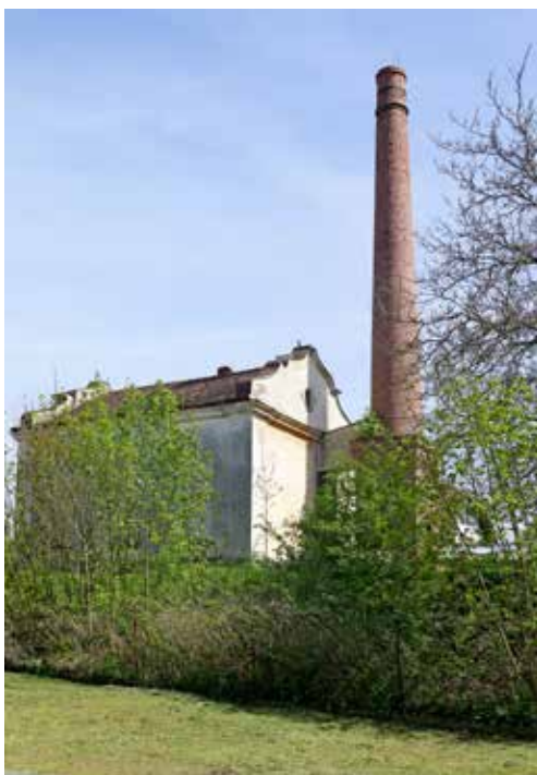
Obr. 3. Horažďovice, čerpací stanice parostrojní drážní vodárny, pohled od západu, zdroj: NPÚ, ÚOP v Plzni, foto: autor, 2023
