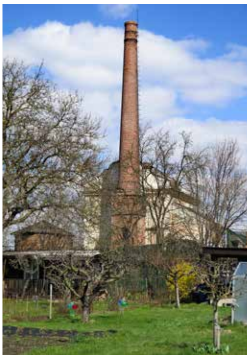
Obr. 2. Horažďovice, čerpací stanice parostrojní drážní vodárny, pohled od jihovýchodu, zdroj: NPÚ, ÚOP v Plzni, foto: autor, 2023
