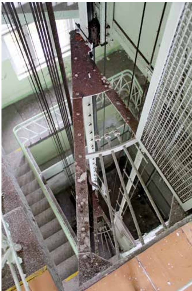
Obr. 5. Karlovy Vary, Bezručova čp. 1090, masivní stabilizační konzole původního výtahu, zdroj: NPÚ, ÚOP v Lokti, foto: autor 2021
