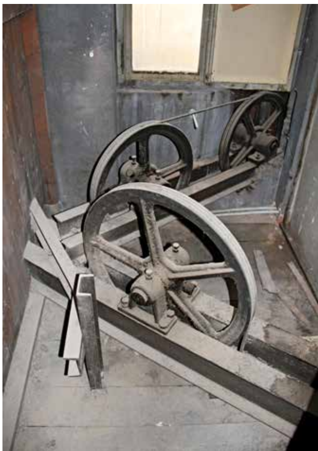
Obr. 2. Karlovy Vary, Tržiště čp. 380, převodová lanová kola dochovaná v podkrovní technické místnosti v domě Tři jehňátka, zdroj: NPÚ, ÚOP v Lokti, foto: autor 2022
