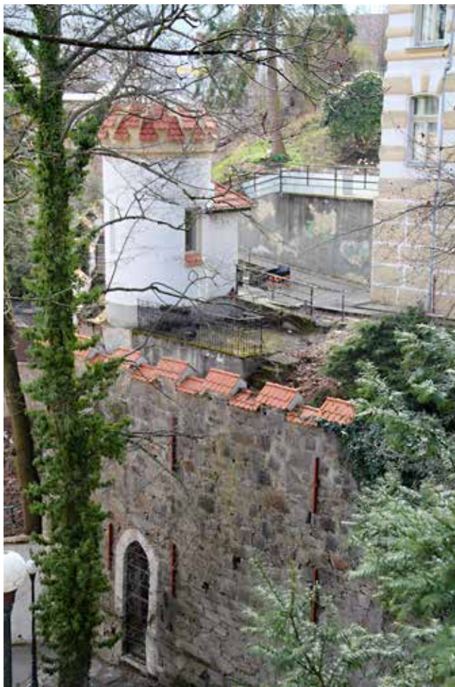
Obr. 4. Karlovy Vary, Zahradní čp. 1044, výtahová věž s cimbuřím provedená v romantizujícím duchu, zdroj: NPÚ, ÚOP v Lokti, foto: autor 2021
