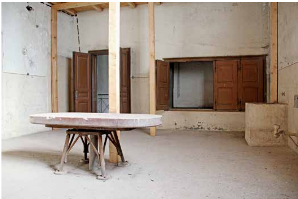
Obr. 6. Karlovy Vary, Hřbitovní čp. 1070, manipulační otvor výtahové šachty v pitevně městské márnice, zdroj: NPÚ, ÚOP v Lokti, foto: autor 2021
