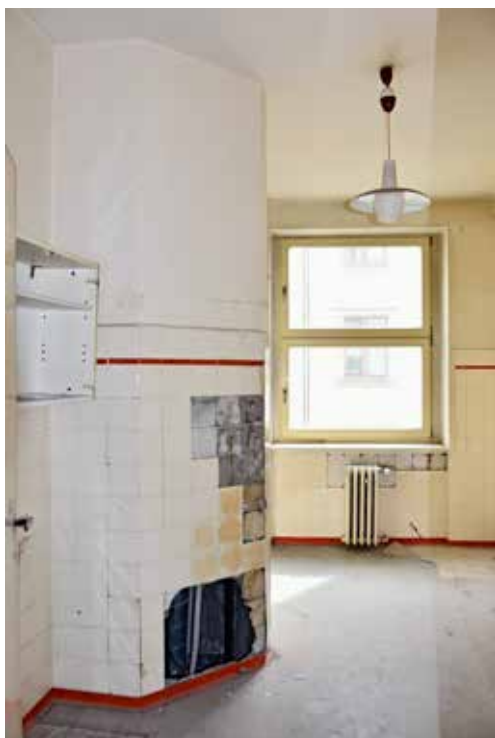
Obr. 8. Karlovy Vary, Zeyerova čp. 892, výtahová šachta v domě Danzing, zdroj: NPÚ, ÚOP v Lokti, foto: Lubomír Zeman 2022
