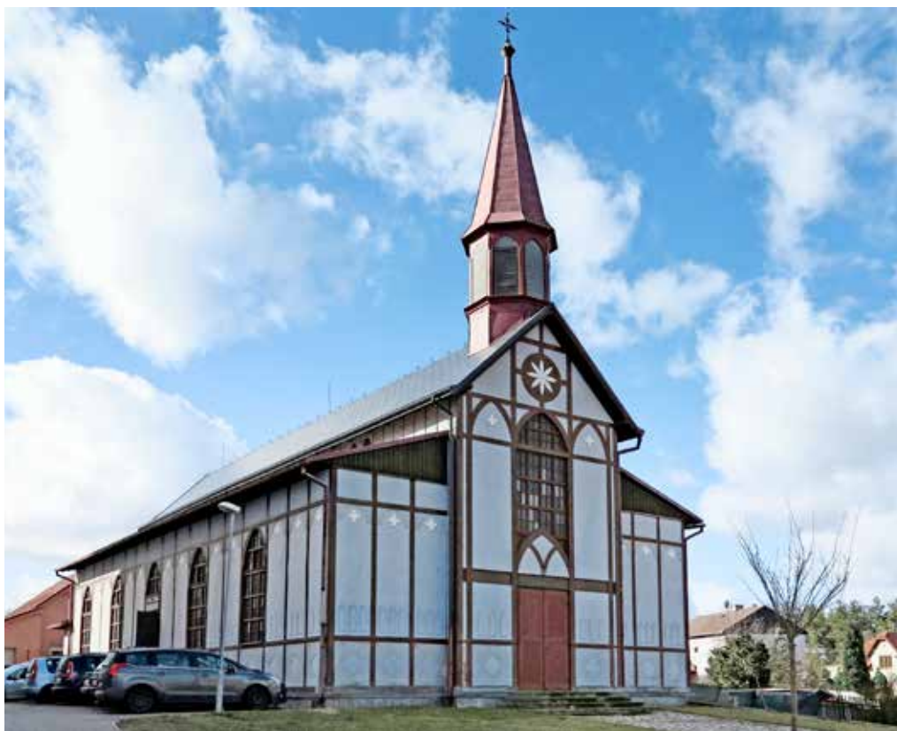
Obr. 7. Nové Sedlo, kostel Nanebevstoupení Páně, zdroj: NPÚ, ÚOP v Lokti, foto: Tomáš Kárník, 2017
