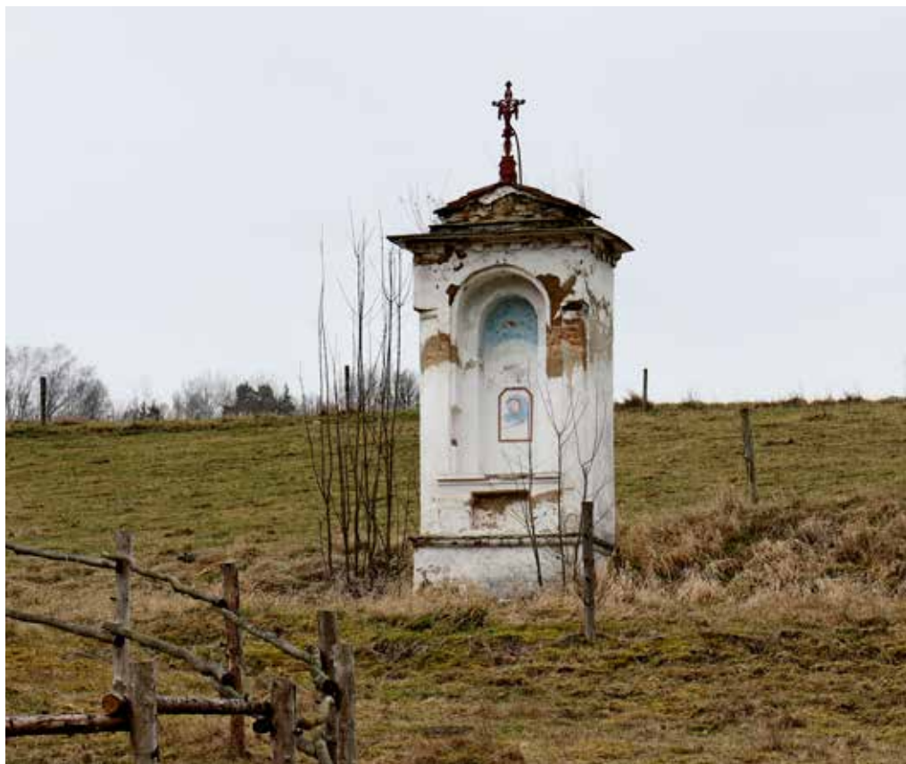
Obr. 12. Salajna, část obce Dolní Žandov, výklenková kaple, zdroj: NPÚ, ÚOP v Lokti, foto: Lukáš Smola, 2020
