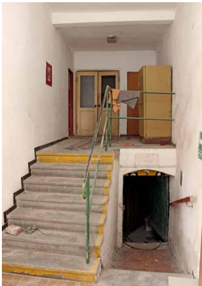
Obr. 5. Horšovský Týn, Husovo náměstí, budova bývalého arciděkanství čp. 60, jižní křídlo, respektive jihozápadní nároží, pohled do haly se schodištěm do místnosti ve zvýšeném přízemí jižního křídla (vlevo) a ke vstupu do suterénu pod jižním křídlem (vpravo), zdroj: NPÚ, ÚOP v Plzni, foto: autor, 2022
