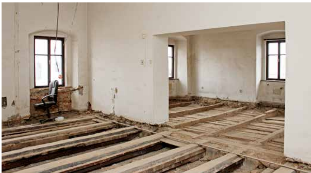
Obr. 7. Horšovský Týn, Husovo náměstí, budova bývalého arciděkanství čp. 60, jižní křídlo, místnosti v patře, pohled severovýchodním směrem, stav po rozkrytí podlah a odhalení konstrukcí původně záklonových a povalových stropů, zdroj: NPÚ, ÚOP v Plzni, foto: autor, 2022
