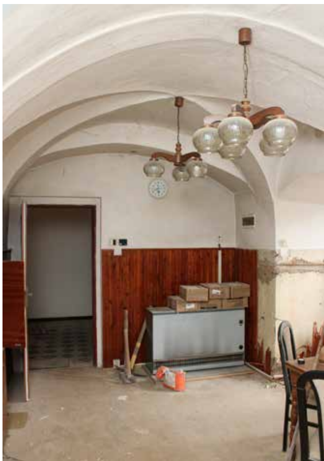
Obr. 6. Horšovský Týn, Husovo náměstí, budova bývalého arciděkanství čp. 60, místnost ve zvýšeném přízemí jižního křídla, pohled od východu západním směrem ke dveřím do vstupní haly, zdroj: NPÚ, ÚOP v Plzni, foto: autor, 2022
