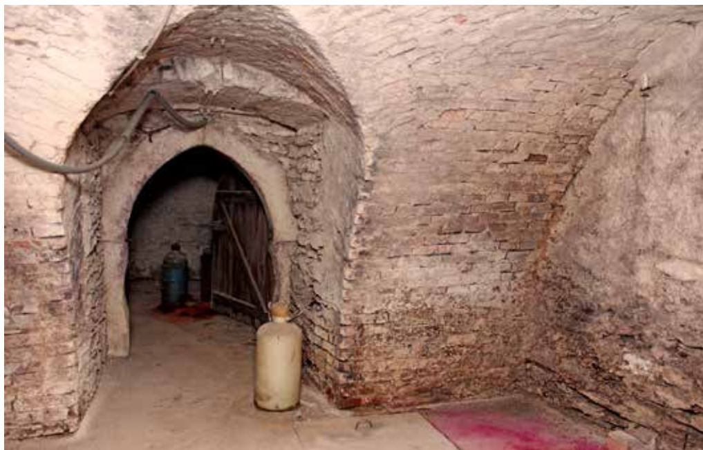
Obr. 4. Horšovský Týn, Husovo náměstí, budova bývalého arciděkanství čp. 60, suterén, střední díl – komora, pohled východním směrem na vstup s gotickým lomeným portálem do východní komory, zdroj: NPÚ, ÚOP v Plzni, foto: autor, 2022
