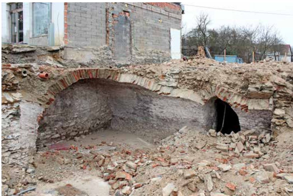
Obr. 9. Horšovský Týn, Husovo náměstí, budova bývalého arciděkanství čp. 60, suterén pod jižním křídlem, střední část, pohled od severovýchodu jihozápadním směrem, stav v průběhu demolice, zdroj: NPÚ, ÚOP v Plzni, foto: autor, 2023
