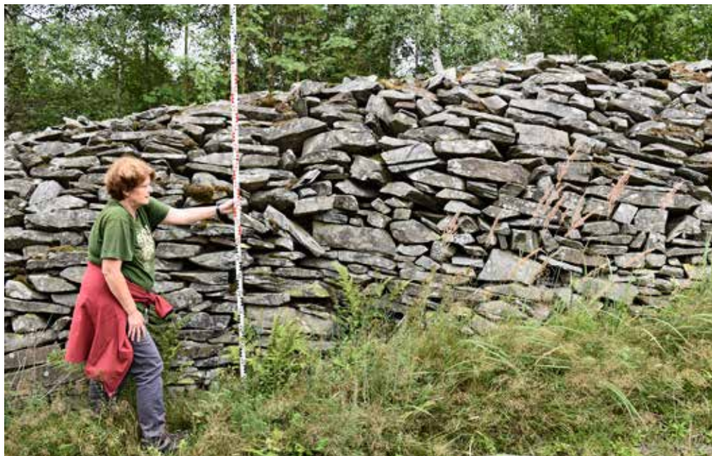
Obr. 10. Komora, precizně skládaná kamenice o výšce 2 m a šířce 5 m, foto: Tomáš Nitra, 2021
