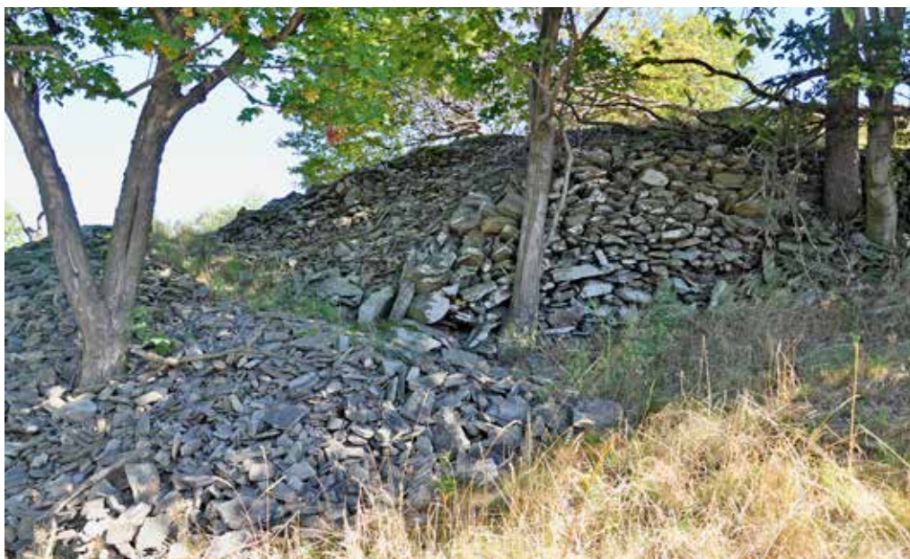
Obr. 16. Valštejn, stezka přechodu pasoucího se skotu přes 2 m vysokou skládanou kamenici a její rozpad, foto: Tomáš Nitra, 2018
