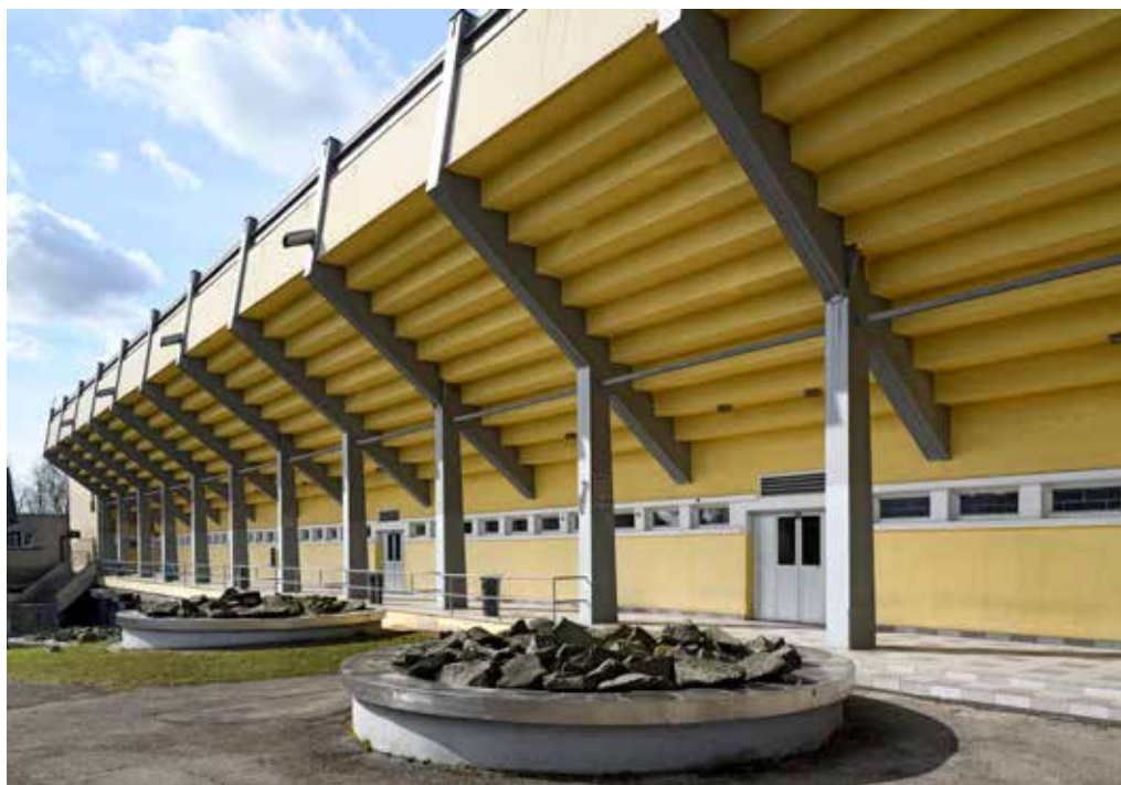
Obr. 2. Víceúčelová hala (nyní Gascontrol Aréna), boční východní průčelí s chrliči a místy pro jímání dešťové vody ze střechy haly, Havířov-Podlesí, 1965–1968, Josef Hrejsemnou, Stavoprojekt Ostrava, foto: Roman Polášek, 2019
