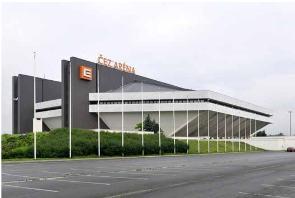
Obr. 11b. Palác kultury a sportu (nyní Ostravar Aréna), celkový pohled od jihovýchodu, Ostrava-Zábřeh, 1976–1986, Vladimír Dedeček, Stavoprojekt Bratislava, foto: Roman Polášek, 2009
