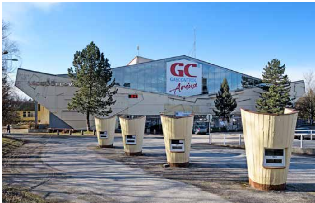
Obr. 1. Víceúčelová hala (nyní Gascontrol Aréna), hlavní průčelí s prodejními stánky, Havířov-Podlesí, 1965–1968, Josef Hrejsemnou, Stavoprojekt Ostrava, spolupráce sochař Václav Uruba, foto: Roman Polášek, 2019
