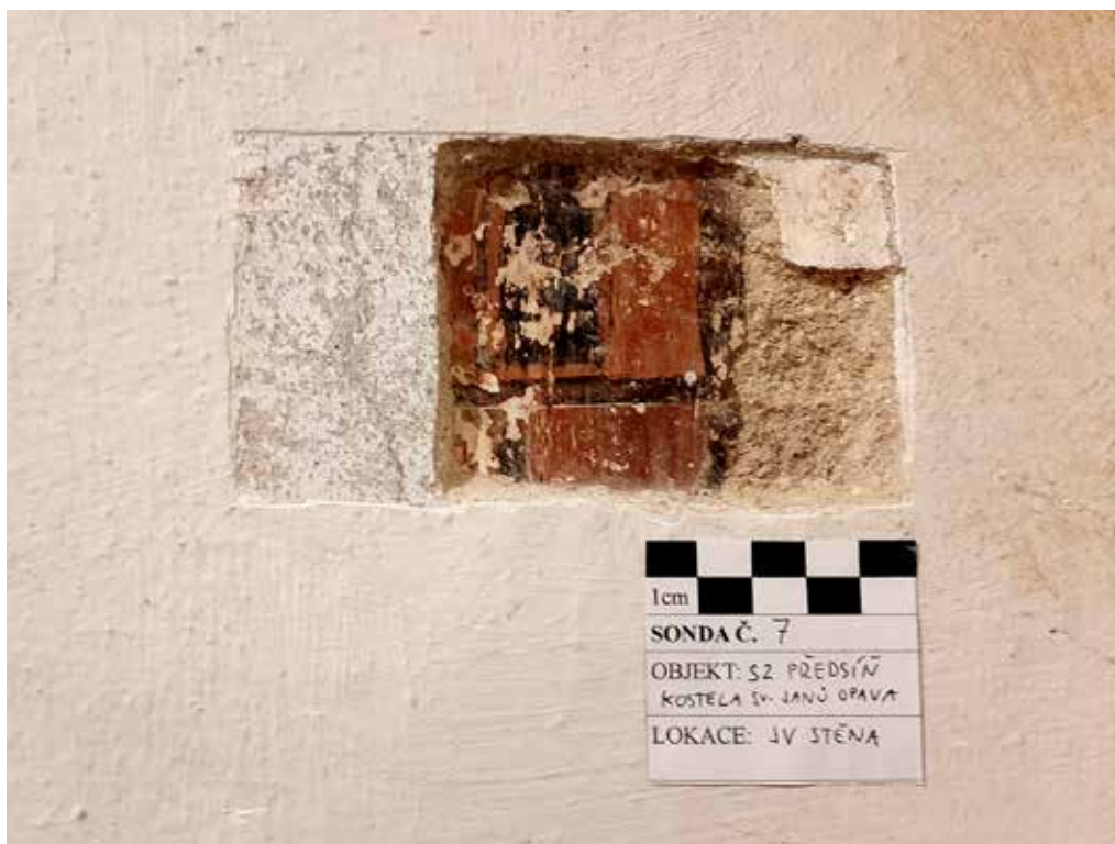
Obr. 1. Kostel sv. Jana Křtitele v Opavě, sonda na jihovýchodní stěně, zdroj: Dalibor Halátek, 2023
