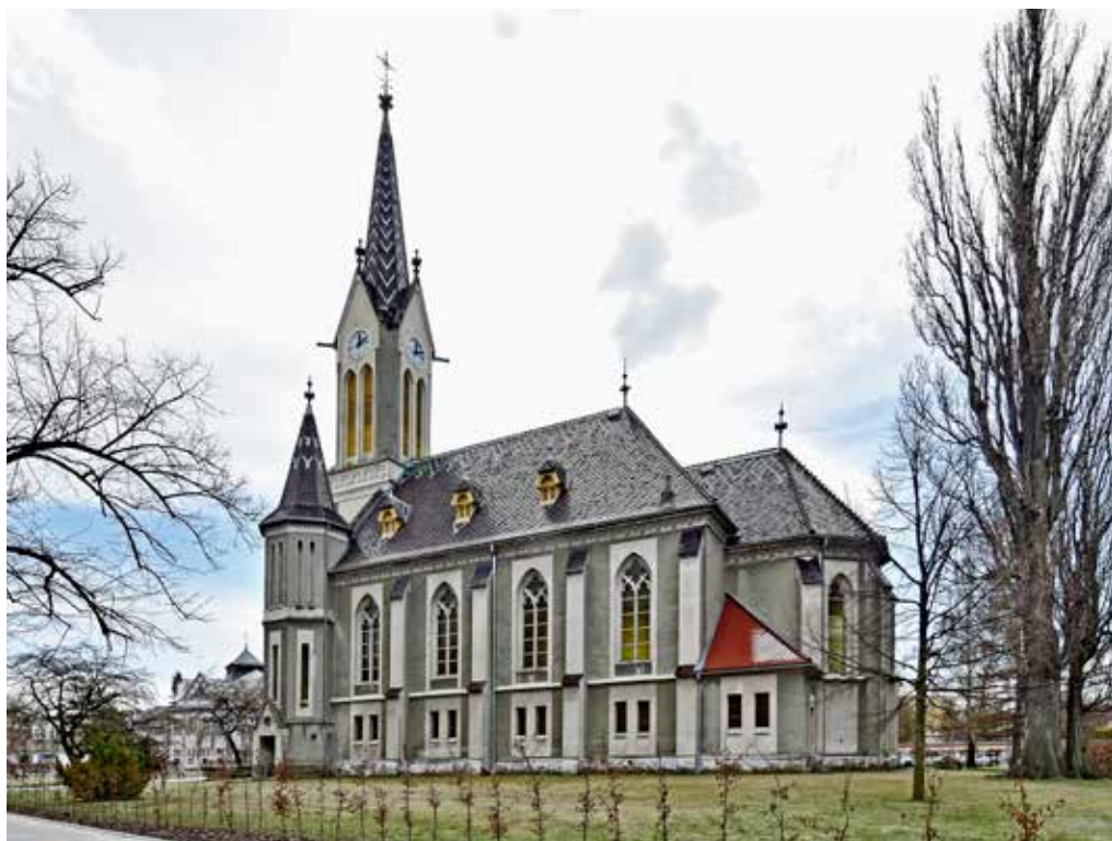
Obr. 2. Krnov, č. o. Pod Bezručovým vrchem, evangelický kostel, pohled od severozápadu, zdroj: Fotoarchiv NPÚ, ÚOP v Ostravě, foto: Gabriela Čočková, 2022
