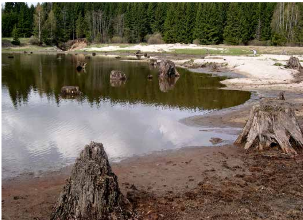
Obr. 12. Nádrž Zlatá Ktiš po protržení hráze (v pozadí snímku) při povodni, foto: Michal Bureš, květen 2003
