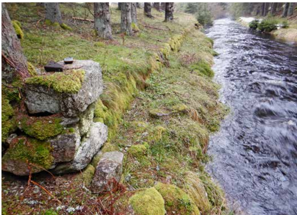
Obr. 2. Pohořský potok, kamenné opevnění břehu navazující na pozůstatky mostku v níže položených partiích zaniklé vsi Jiříce nedaleko Baronova mostu, nad hladinu potoka vyvýšená kamenná zeď, snad opevnění pro případ vzduté hladiny při umělé povodňové vlně, foto: Michal Bureš, duben 2023
