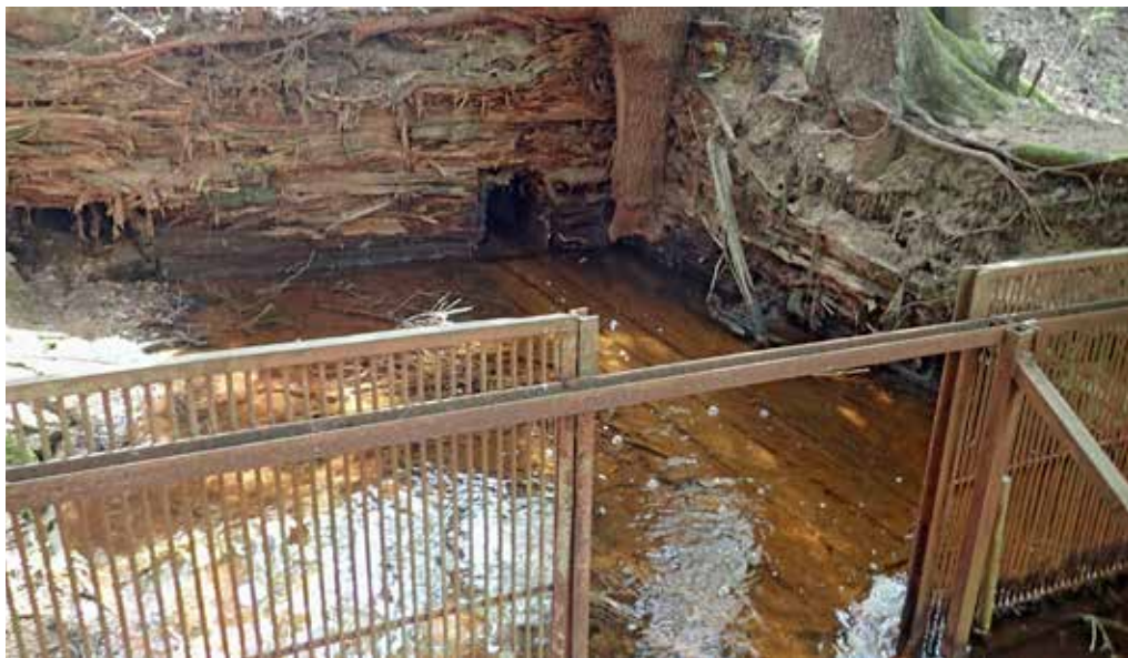
Obr. 22. Huťský rybník, část tzv. pražce ovšem v nešetrné moderní úpravě, odstraněné dřevěné pažení zadržující vodu v pražci, nahrazené propustnou železnou mříží, viditelné obě dřevěné roury regulující množství vody pouštěné do systému v době plávky, dnes roury vystavené vlivu vzduchu a degradované, foto: Michal Bureš, červenec 2024
