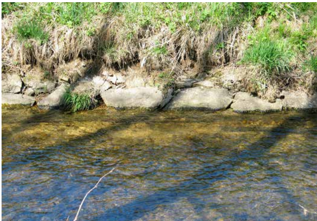
Obr. 3. Černá, kamenné obezdění břehů ukotvené na dřevěné trámy uložené souběžně s tokem pod hladinou vody na 12 kilometru, foto: Jan Pařez, květen 2003
