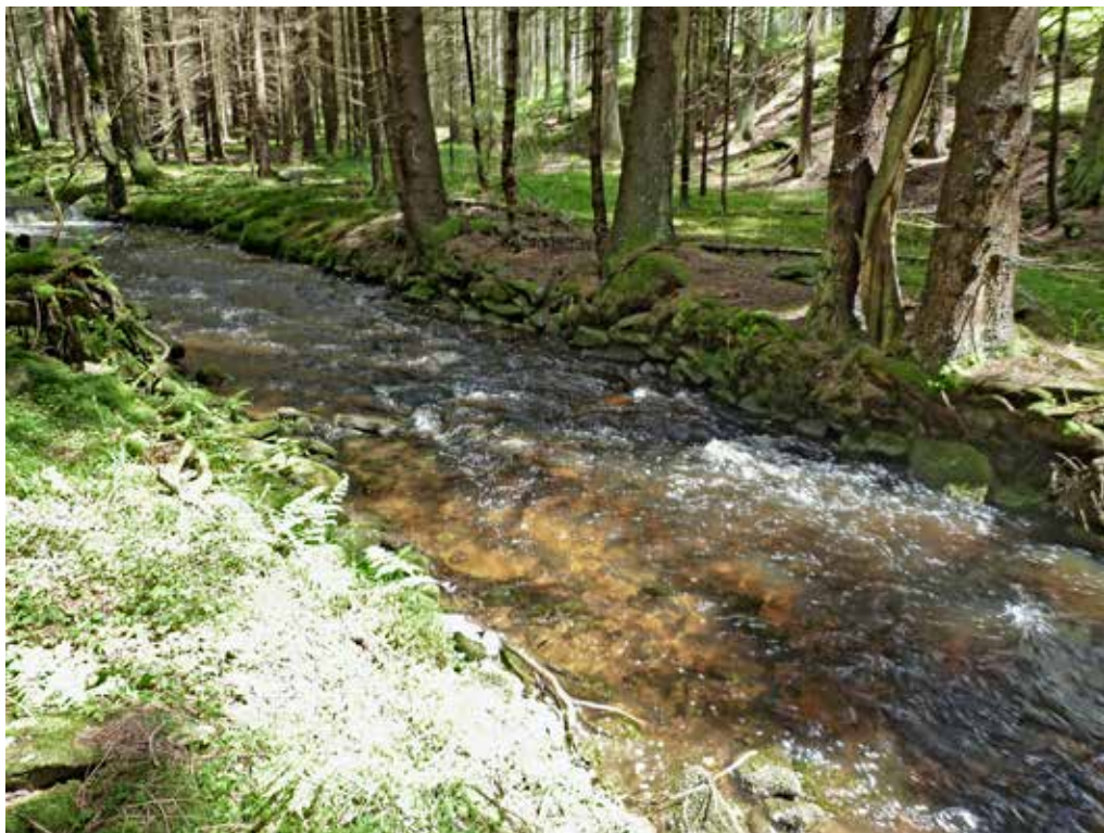
Obr. 16. Lužný potok (Luggaubach), v části protékající zaniklou osadou Starý Holand napřímený, břehy zpevněné kamenným opevněním, foto: Michal Bureš, červen 2020
