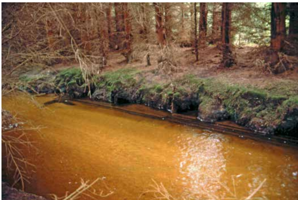
Obr. 1. Černá, výdřeva (tzv. epis) pod bývalým Leberhartským rezervoárem nedaleko osady Žofín, stav před velkými povodněmi, foto: Michal Bureš, květen 2002
