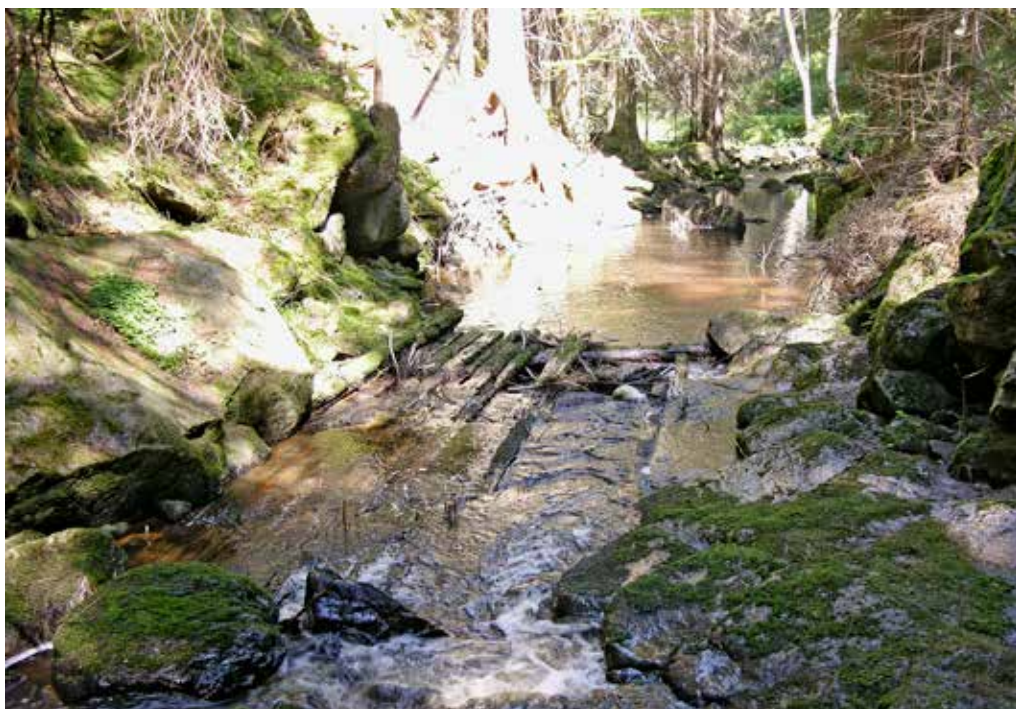
Obr. 32. Pohořský potok, postupná degradace horizontální výdřevy a úbytek její hmoty, foto: Michal Bureš, červenec 2012
