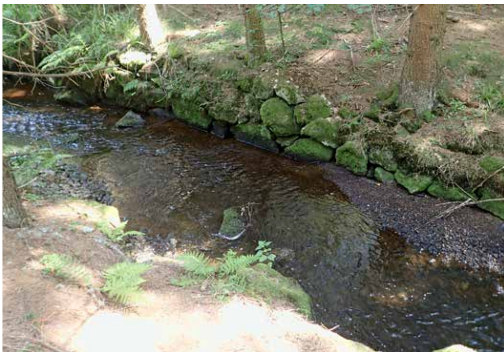
Obr. 7. Huťský potok, kamenná úprava ve střední pasáži toku, dolní část toku u Žofína před soutokem s Černou upravená výdřevou, foto: Michal Bureš, červenec 2024
