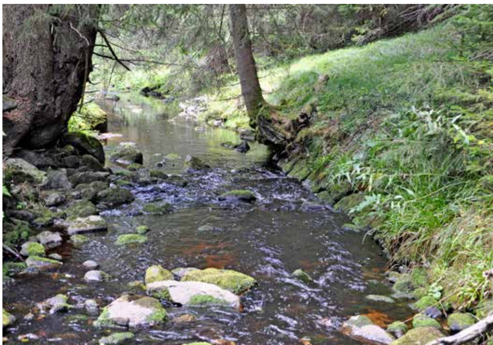
Obr. 29. Pohořský potok, kamenné opevnění břehu pod Mittlere Zeughütten, foto: Michal Bureš, červenec 2024
