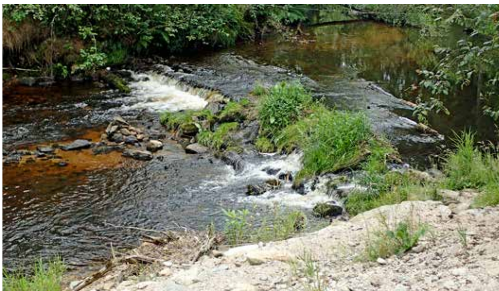
Obr. 14. Hauslův jez (Hauslwehr) těsně pod soutokem Pohořského potoka a Černé, pod hladinou zachované i některé dřevěné konstrukce, nad hladinou fragmenty kamenných konstrukcí i malý fragment původního dřevěného srubu, foto: Michal Bureš, červenec 2024
