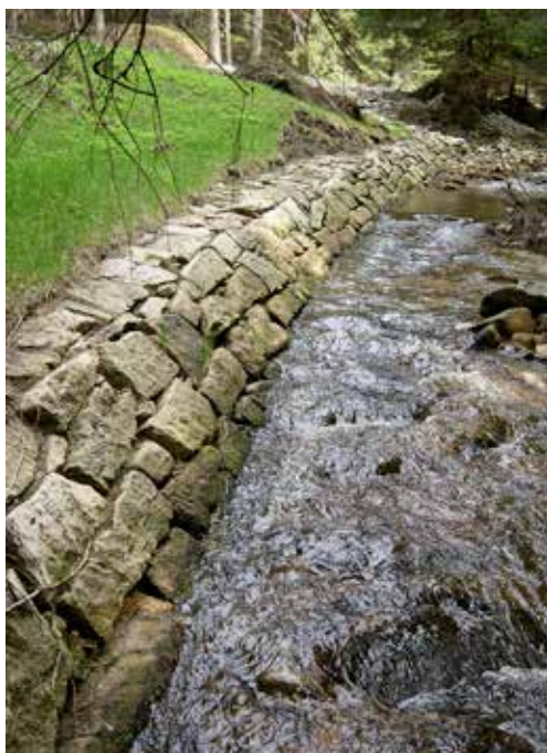
Obr. 4. Pod nádrží Zlatá Ktiš, ohbí toku precizně vystavěné z opracovaných kamenných kvádrů odhalené vodou protržené hráze, dnes je zdívo opět z větší části zarostlé vegetací, foto: Michal Bureš, květen 2003
