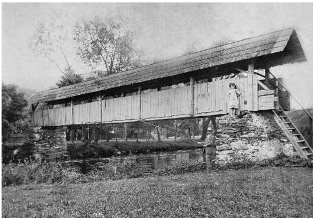
Obr. 33. Švařec, krytá lávka na řece Svatce (okr. Žďár nad Sázavou), foto: 1910, zdroj: soukromá sbírka
