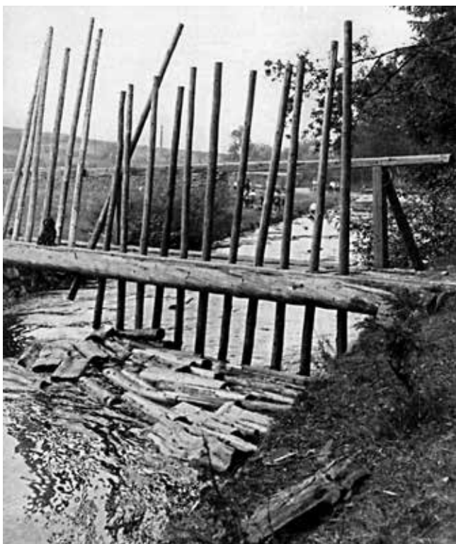
Obr. 16. Jednoduché rechle s brlením prostrčenými otvory vyvrtanými v nosníku na Vchynicko-tetovském kanále, zdroj: ROUČKA, Zdeněk, Předválečná Šumavou. Život – práce – krajina , Plzeň 2006, s. 110
