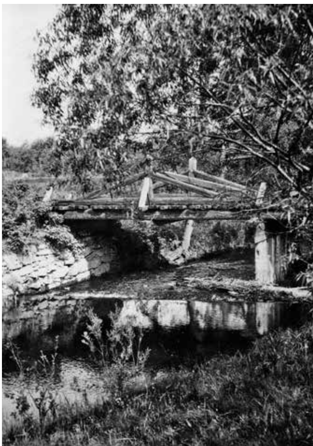
Obr. 32. Zbytky rechlí v Gabriele, foto: V. Šolc, 1955, zdroj: Etnologický ústav AV ČR, v.v.i., fotodokumentární sbírka Praha, sign. 5936HK
