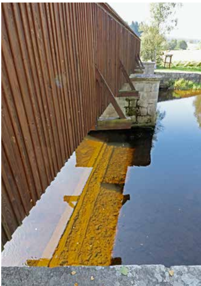
Obr. 24. Lenora, patrné prahové trámy sloužící k upevnění tyčí brlení ve zpevněném dně řeky pod rechlemi, foto: autorka, 2024
