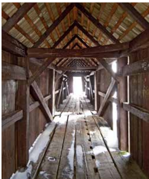
Obr. 21. Lenora, interiér rechlí nazývaných Vogelberg, stav před poslední opravou (2012–2013), trámy již dříve přeskládané při různých opravách (např. v roce 1985), trám s dlaby dendrochronologicky datovaný do šedesátých let 19. století, foto: Radek Liška, 2012
