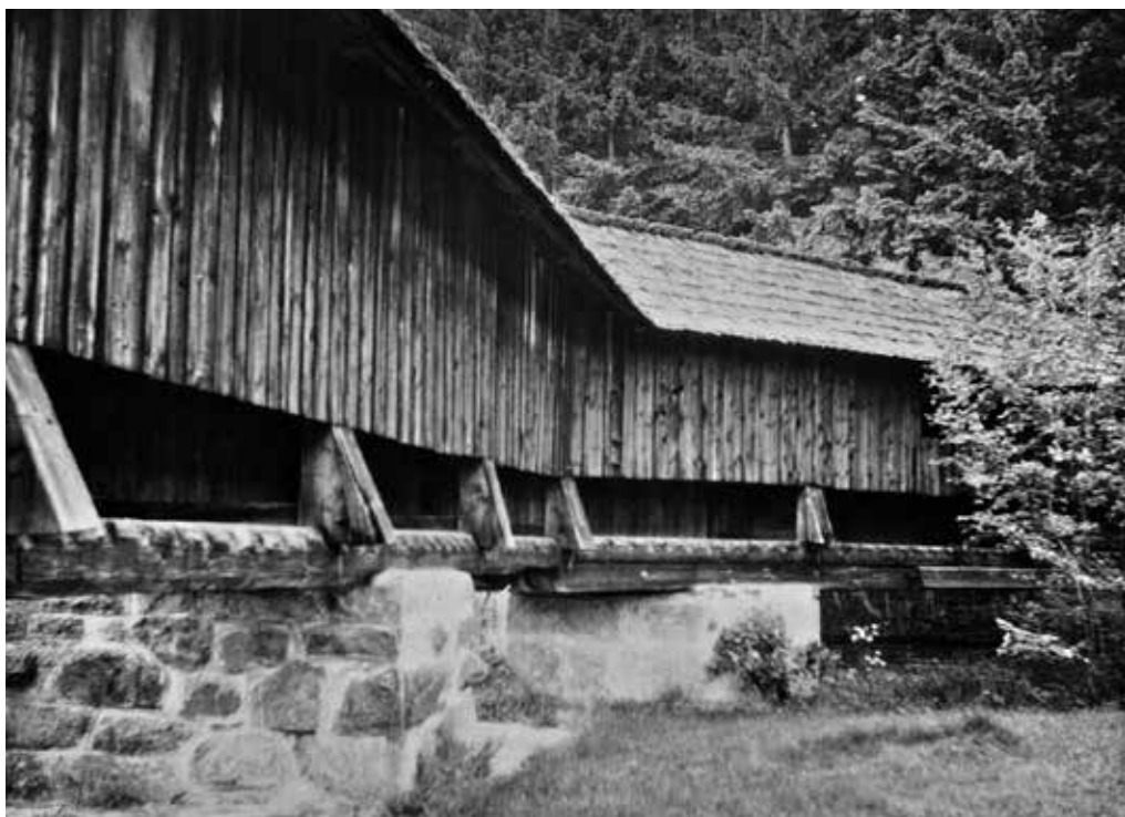
Obr. 6. Blansko u Kaplice, rechle nazývané Ponholz, na pohledu zpredu jsou dobře patrné dlaby v nosníku, do kterého se opíraly tyče brlení, foto: V. Šolc, 1955, zdroj: Etnologický ústav AV ČR, v.v.i., fotodokumentační sbírka Praha, sign. 5958 HK
