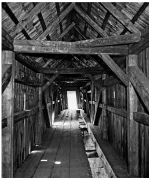
Obr. 20. Lenora, interiér rechlí nazývaných Vogelberg, patrná mezera před trámem opatřeným dlaby, foto: M. Posselt, 1965, zdroj: fotoarchiv NPÚ, GnR, sbírka fotografické dokumentace
