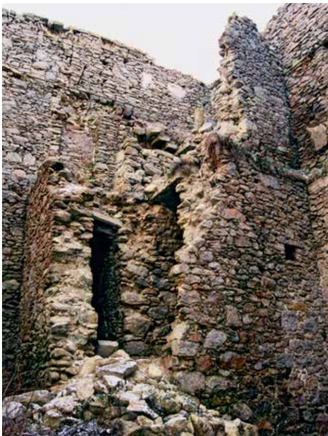
Obr. 3. Vítkův Kámen, torzo kamené rozhledny vestavěné do hradní věže v závěru 19. století, stav krátce před jejím rozebráním, foto: autor, 2002
