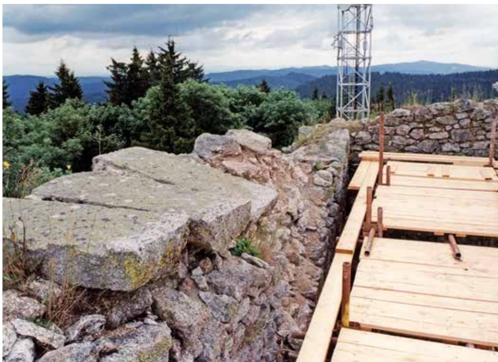
Obr. 6. Vítkův Kámen, kamenné desky, kterými byla koruna věže překryta po odstranění zděných štítů, foto: autor, 2004
