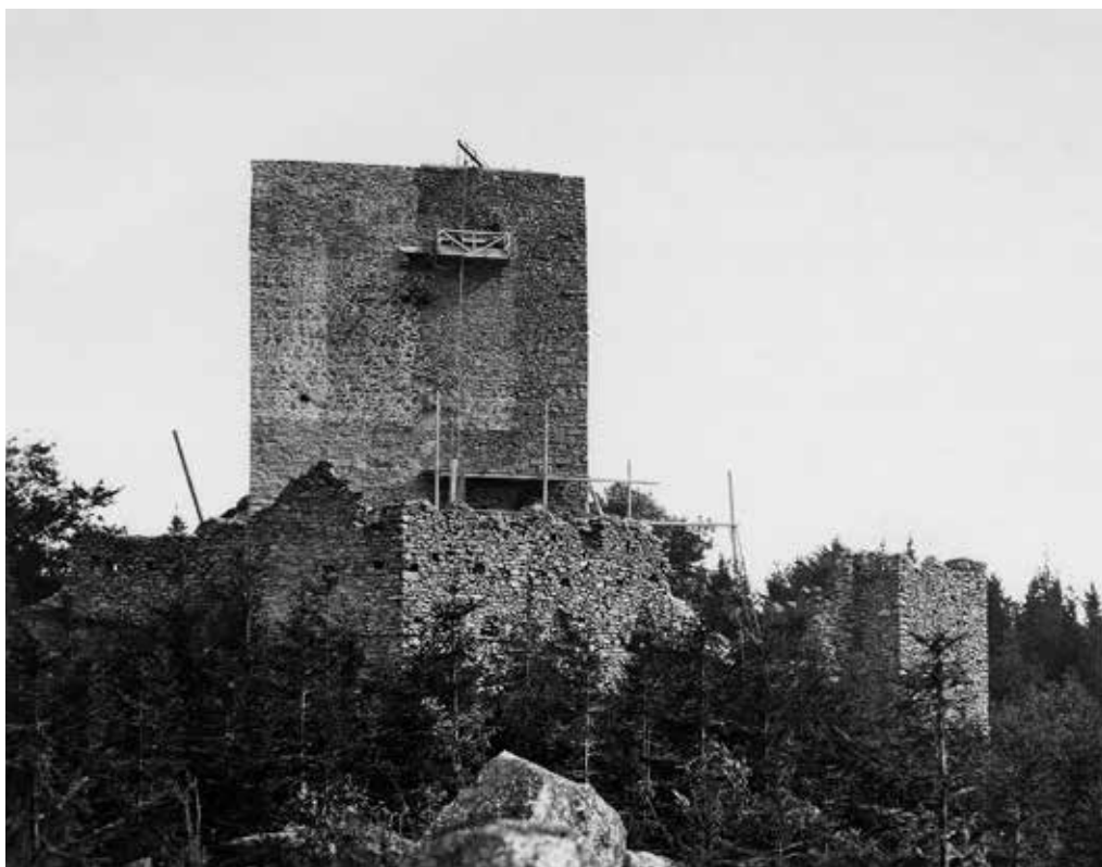
Obr. 9. Vítkův Kámen, vnější průčelí obytné věže spárované pomocí závěsné plošiny, foto: 1934, zdroj: SOA v Třeboni, odd. Český Krumlov, fond Sběrka fotografií Český Krumlov 1880–1991, inv. č. 4480A
