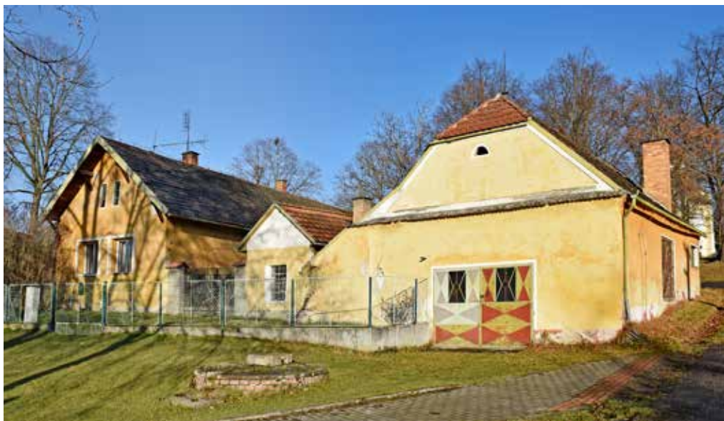
Obr. 27. Čičenice, usedlost čp. 11 s kovárnou, foto Zdeněk Štěpančík, 2021
