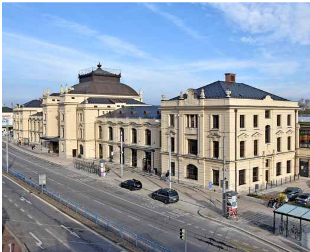
Obr. 1. České Budějovice, železniční stanice po celkové obnově, uliční průčelí, foto: Jana Štorková, 2024
