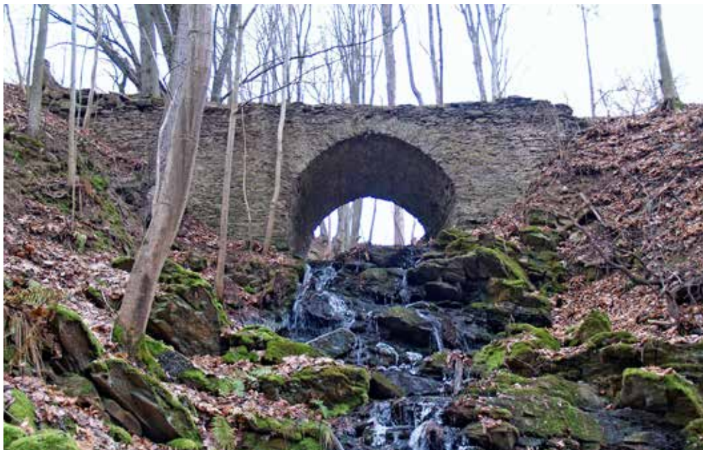
Obr. 6. Nové Dvory u Pořína, kamenný klenutý most, foto: Zdeňka Kočková, 2019
