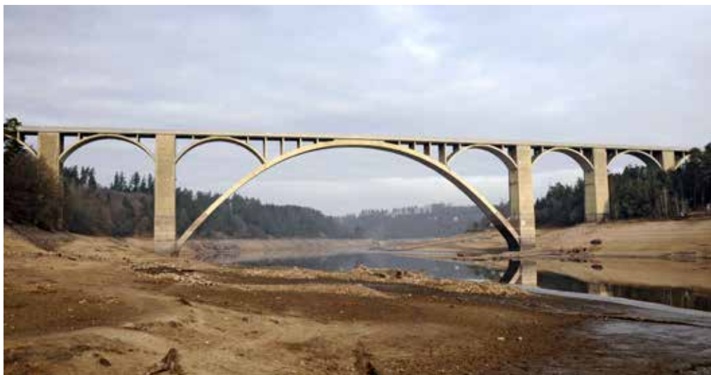
Obr. 5. Podolsko–Temešvár, silniční most nad sníženou hladinou vodního díla Orlík, foto: Pavel Hájek, 2020
