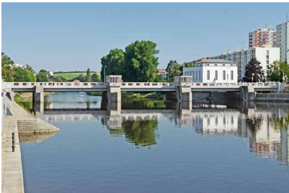
Obr. 3. Písek, silniční most (tzv. Nový) s malou vodní elektrárnou, foto: Jakub Drozda, 2020
