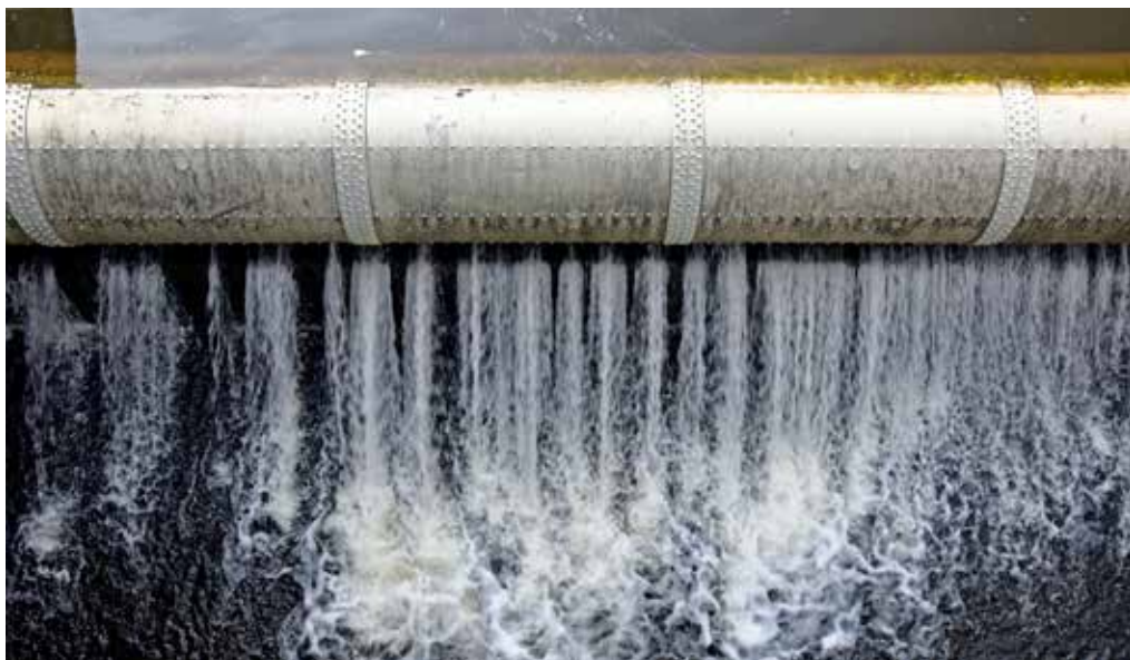
Obr. 4. Písek, silniční most (tzv. Nový), detail válcového jezu, foto: Jakub Drozda, 2022
