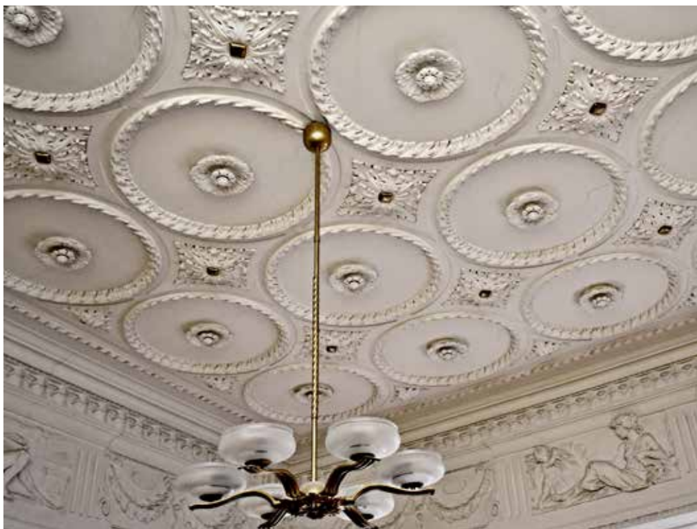
Obr. 19. České Budějovice, Kendeho vila, štuková výzdoba interiéru, foto: Jakub Drozda, 2022
