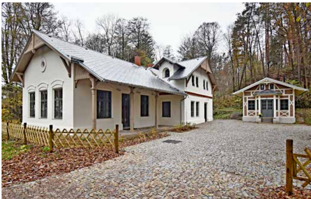
Obr. 8. Jindřichův Hradec, Nežárecká čp. 121, výletní restaurace Rudolfův s altánem po obnově, pohled od východu, foto: Jakub Drozda, 2023
