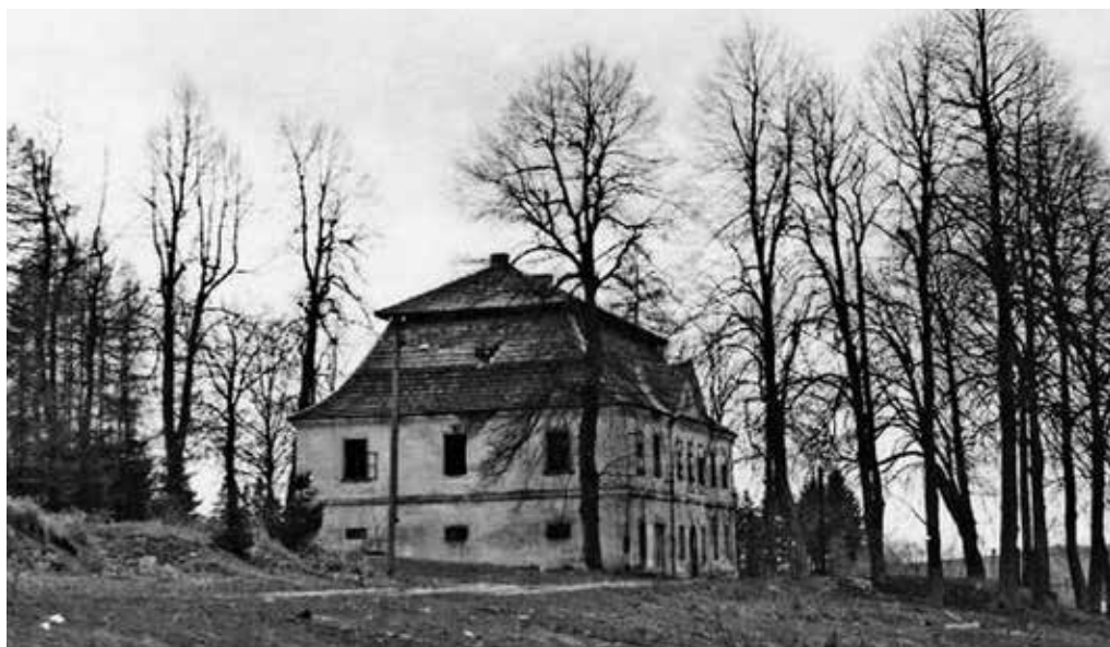
Obr. 1. Albeř u Nové Bystřice, tzv. záměček Terezínov, pohled od východu, foto z roku 1965, zdroj: sbírka majitele
