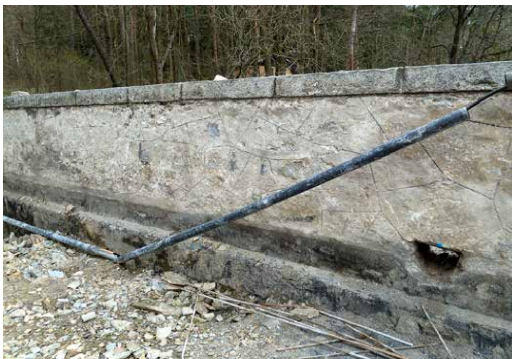
Obr. 3. Římov, Dolní Stropnice, silniční kamenný most v průběhu obnovy, detail nalezeného dekoru imitujícího kyklopské zdivo, foto: Václav Hájek, 2019
