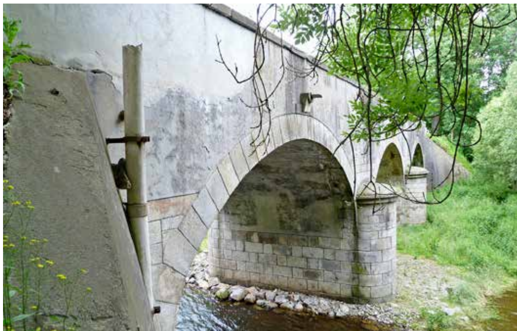
Obr. 1. Římov, Dolní Stropnice, silniční kamenný most přes Malši před zahájením obnovy, pohled od jihozápadu, foto: Václav Hájek, 2016
