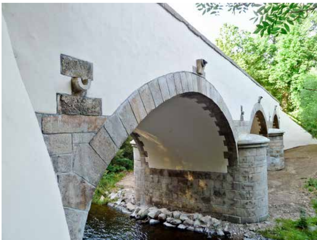
Obr. 2. Římov, Dolní Stropnice, silniční kamenný most přes Malší po stavební obnově, pohled od jihozápadu, foto: Václav Hájek, 2019
