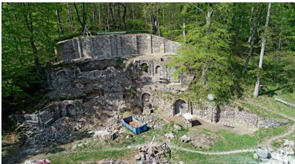
Obr. 10. Výškový pohled na theatron parku státního zámku Valeč v Čechách v průběhu jeho rekonstrukce, foto: Filip Prekop, 2021
