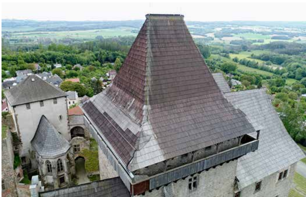
Obr. 7. Státní hrad Lipnice, revizní dokumentace stavu šindelových střech, foto: Pavel Macků, 2020
