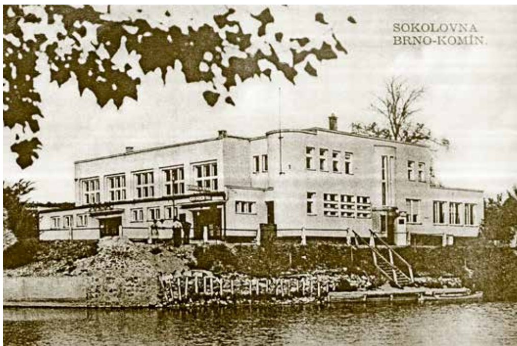
Obr. 8. Brno, Svratecká 198/11, sokolovna v Komíně na dobové pohlednici, archiv NPÚ, MCMA v Brně
