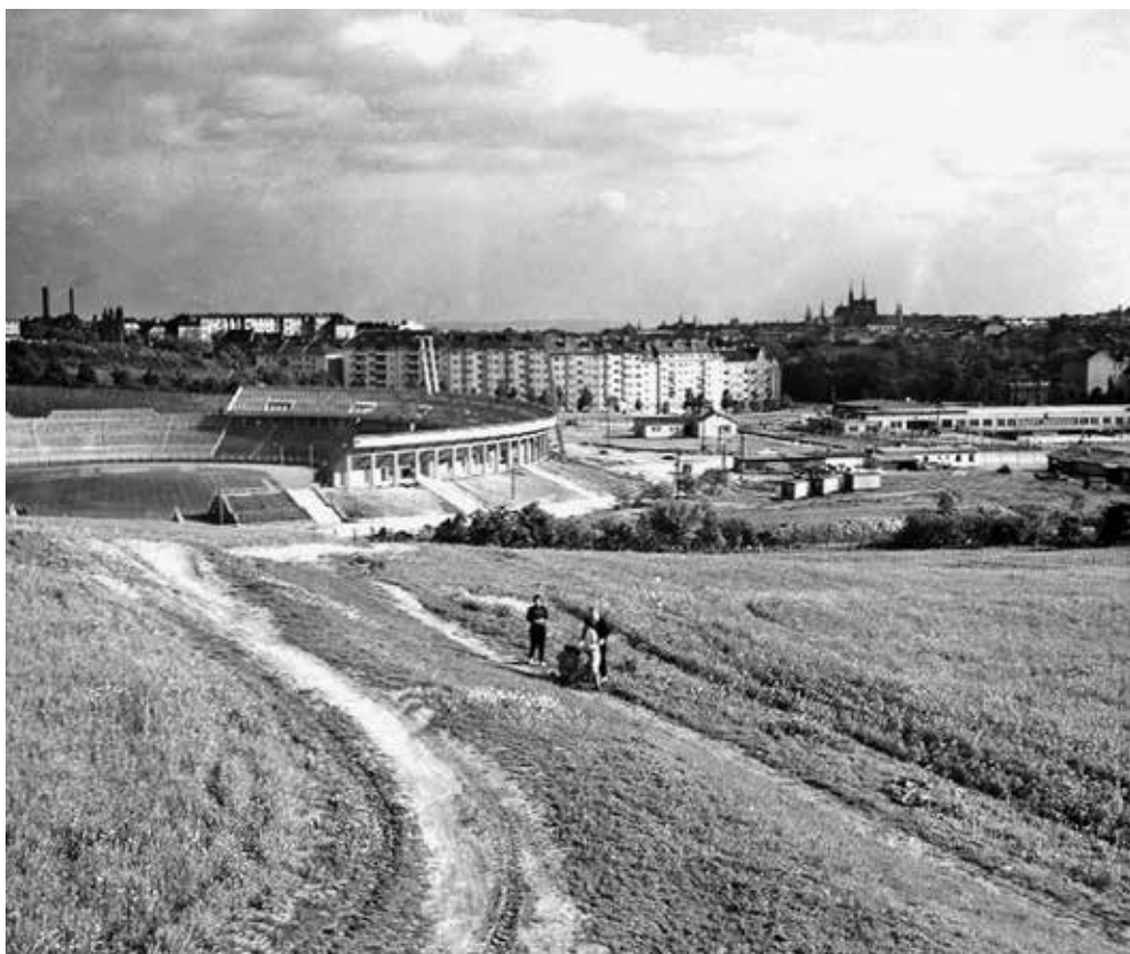
Obr. 10. Brno-Královo Pole, fotbalový stadion za Lužánkami, 1960, archiv NPÚ, ÚOP v Brně, inv. č. 50018
