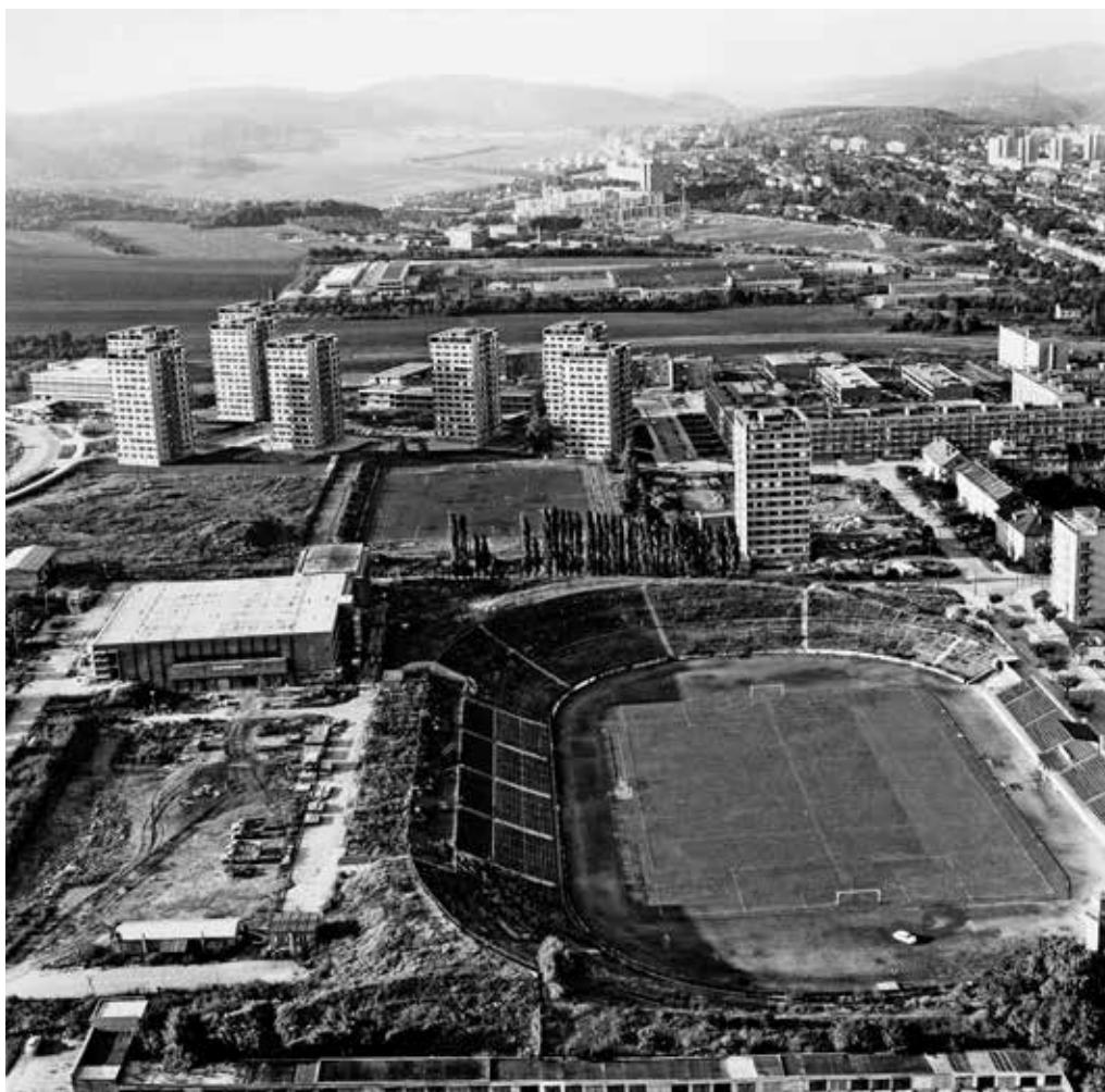
Obr. 13. Brno-Královo Pole, víceúčelová sportovní hala míčových a úpolových sportů, stav při dokončení v roce 1975, archiv NPÚ, MCMA v Brně
