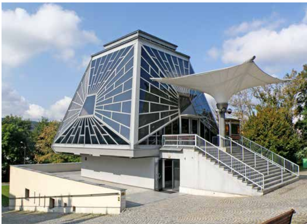
Obr. 11. Smuteční síň Vsetín, soudobé zastřešení přístupového schodiště, foto: NPÚ, Ladislav Buchta, 2018
