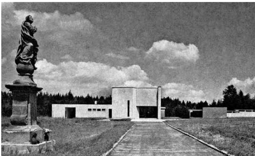
Obr. 3. Smuteční síň v Dolních Kralovicích, krátce po výstavbě na počátku 70. let 20. století, zdroj: PECHAR, Josef, Československá architektura 1945–1977 , Praha 1979, s. 296
