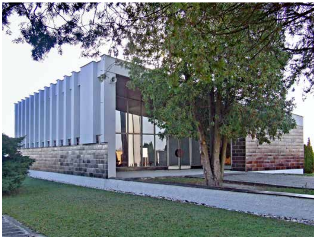
Obr. 4. Smuteční síň v Kosticích, pohled k hlavnímu vstupu od severu, foto: NPÚ, Martin Šolc, 2018
