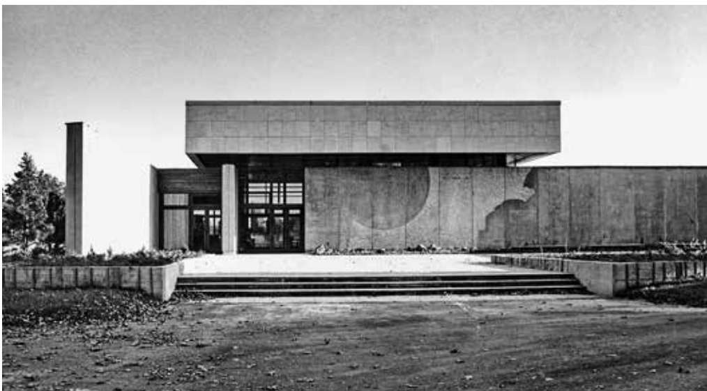
Obr. 18b. Smuteční síň Chrudim, realizovaná stavba po dokončení, reprofoto: archiv Jana Třeštíka
