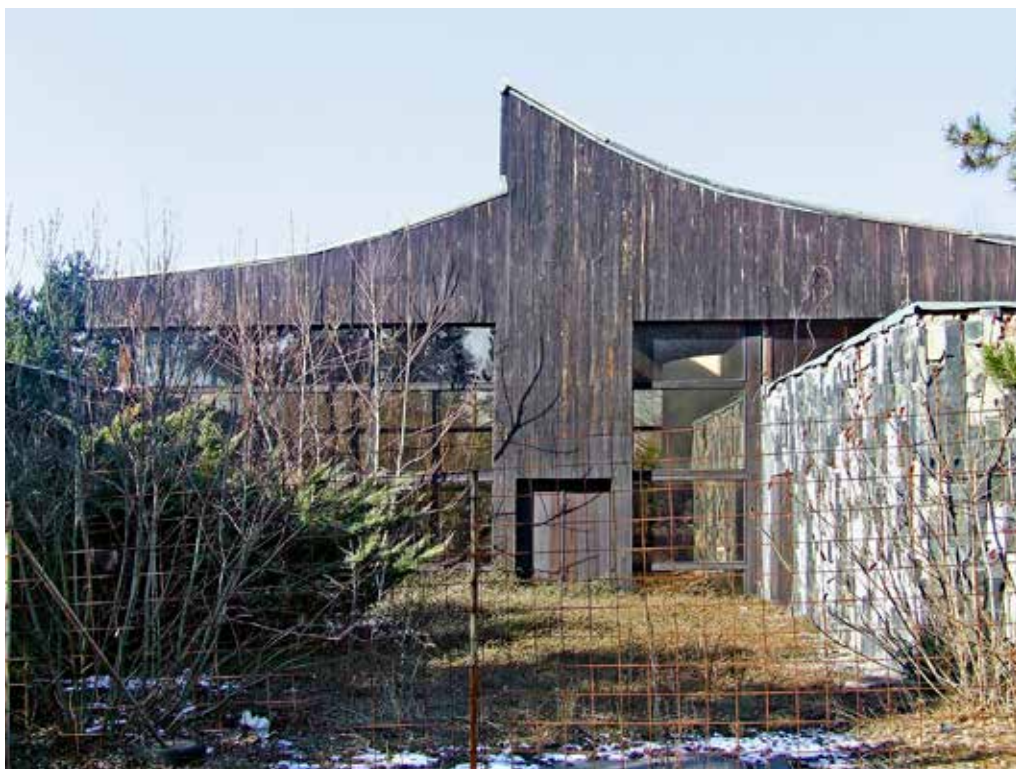
Obr. 20c. Smuteční síň Brno-Židenice, pohled do atria od jihovýchodu, foto: NPÚ, Martin Šolc, 2018
