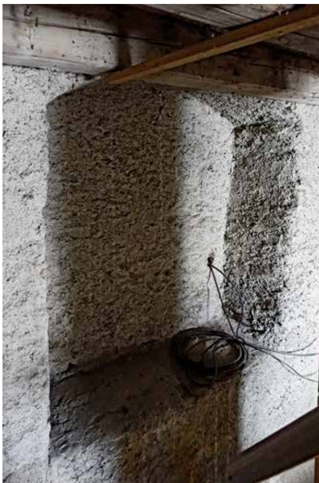
Obr. 19. Štěpánov nad Svratkou, věž. Pohled od severovýchodu na původní zazděný vstup do 1. patra věže, foto: autor, 2020
